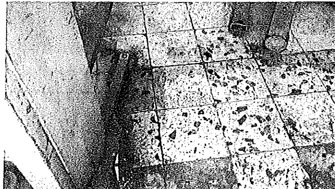
תמונה 1: כתמי נוזל קירור על משטח התפעול במוסך
